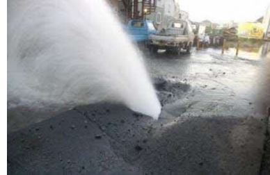
近年県営水道で発生した 漏水事故
