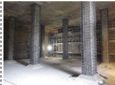
<配水池耐震化工事>
