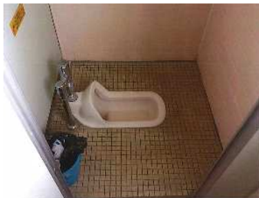
【トイレ改修イメージ】 <改修前>
