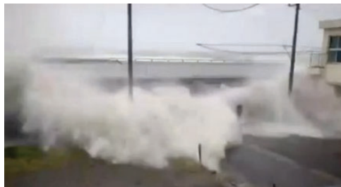
小田原海岸における越波の状況
