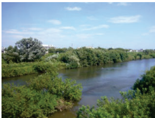
河床掘削・樹木伐採の実施
