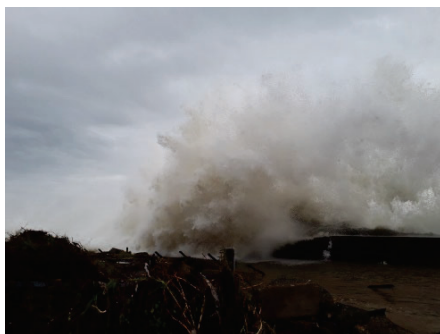
台風による高波が護岸を越えている状況 (平成 29 年台風第 21 号)
