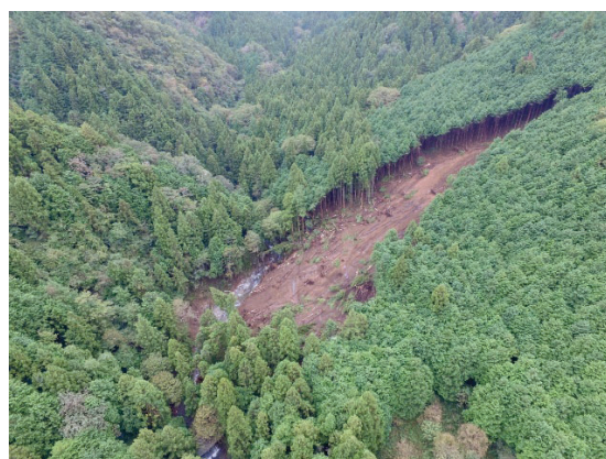
ドローンを使用した上空からの空撮による崩落現場の確認
