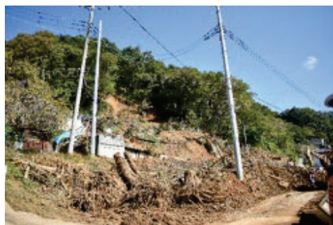
土砂災害警戒区域内のがけ崩れ発生状況
