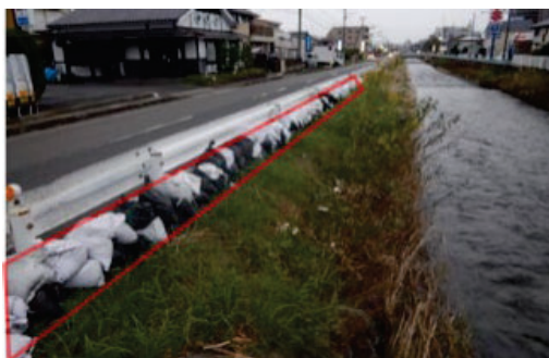
嵩上げコンクリート工事の実施
