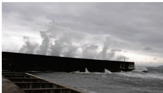
台風による高波が防波堤を越えている状況
