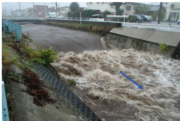
平成 26 年台風第 18 号における出水状況 (山王川)
