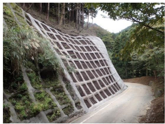
唐沢林道 法面保護工（清川村）
