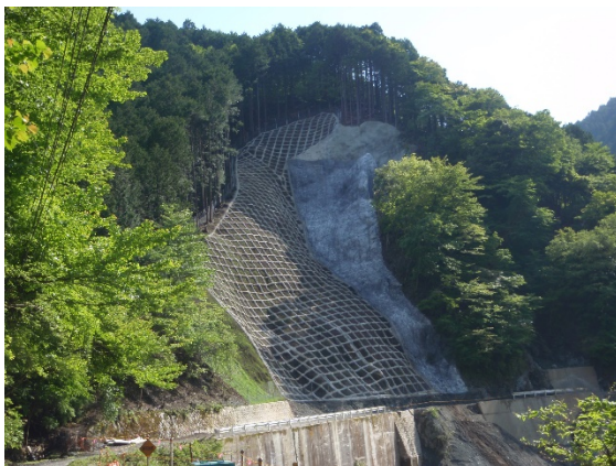
山腹工施工地（山北町）
