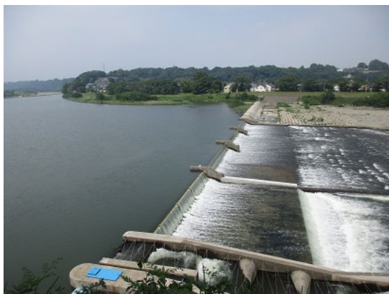
小沢頭首工（相模原市・愛川町）
