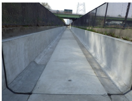
相模川左岸用水路（海老名市）
