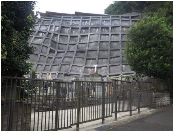
法面防災工事（鎌倉市）
