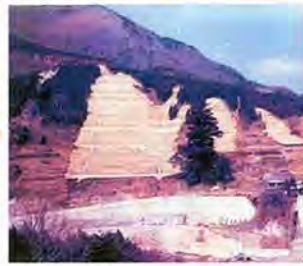
○山腹工施工状況（昭和49年）
