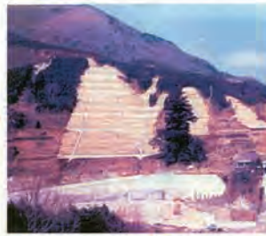
○山腹施工状況（昭和49年）
