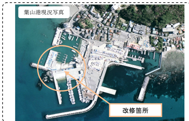
<船舶保管地の改修箇所>
