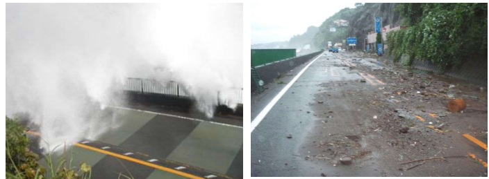
平成19年台風9号による越波被災状況
