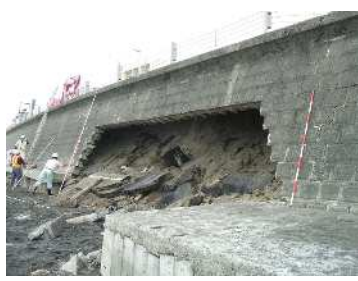
平成21年台風18号による被災状況 擁壁の崩落
