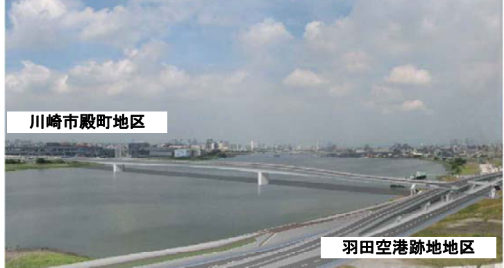
羽田連絡道路完成後のイメージ
