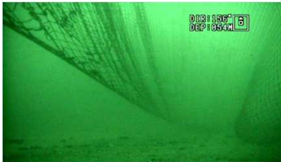
図4-14 運動場の網及び昇網と海底の隙間
