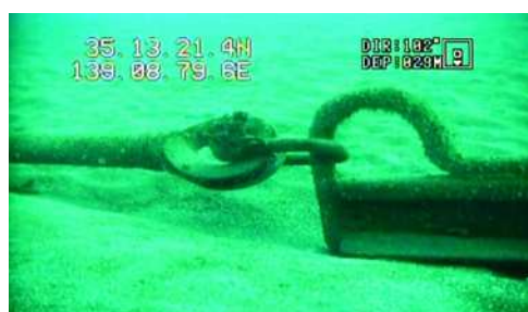
図 4 - 4 接合部のシャックル
