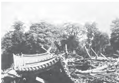
倒壊した遊行寺(藤沢市)
