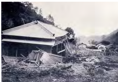
山津波の被害を受けた大山町(伊勢原市)
