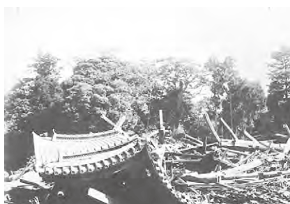
倒壊した遊行寺 (藤沢市)
