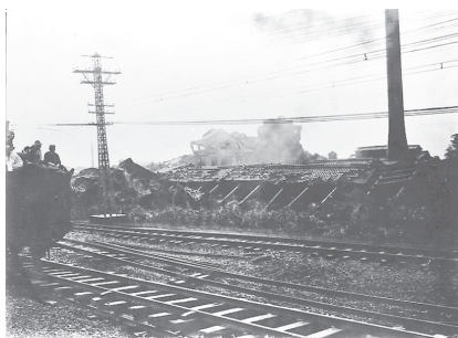
建物19棟が全壊した富士瓦 紡績川崎工場(川崎市)
