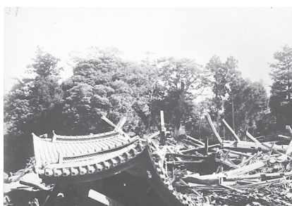
倒壊した遊行寺 (藤沢市)
